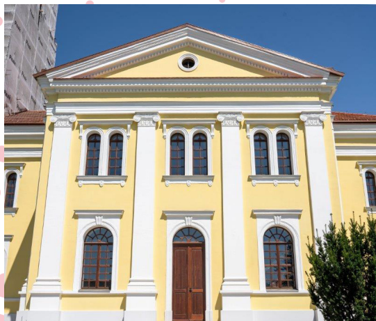
Renovácia Reformovaného kostola v Kunmadarasi
