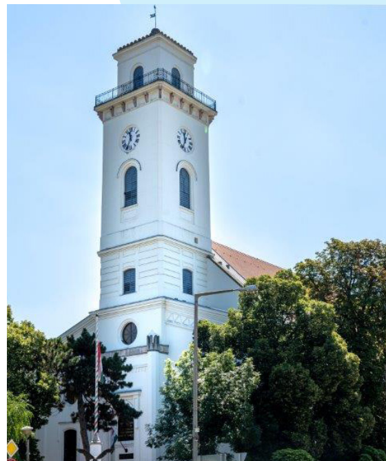
Renovácia Reformovaného kostola v Karcagu (Maďarsko).
