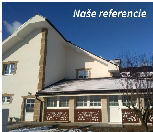
Renovácia Reštaurácie Lehôtka pod Brehmi
