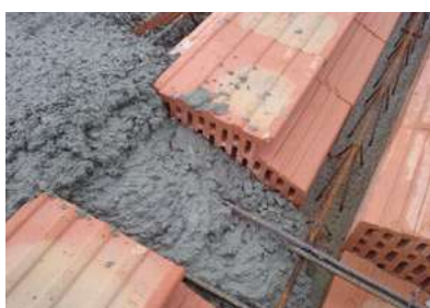
Detail stropu počas betónáže
